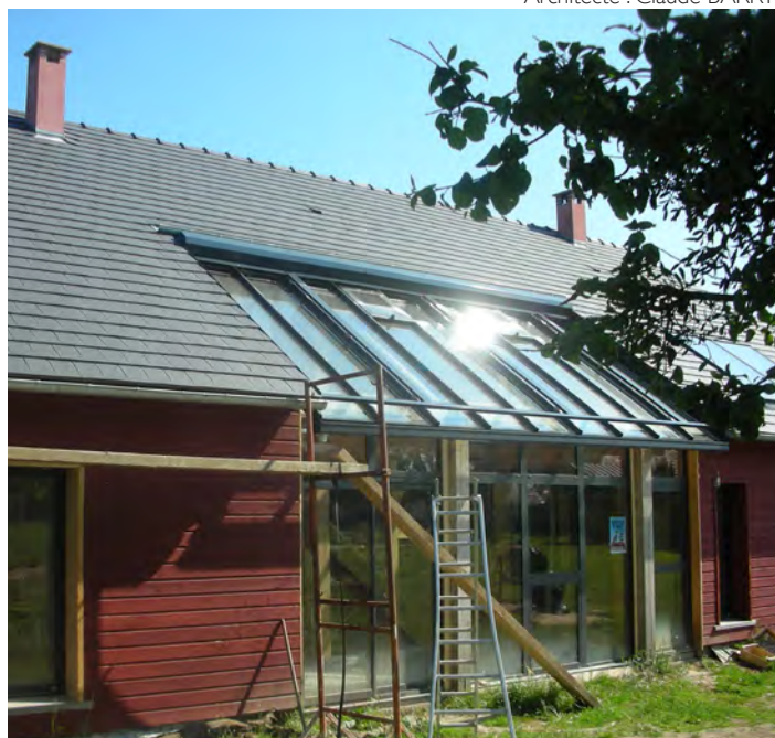
Création d'une verrière dans un volume traditionnel
