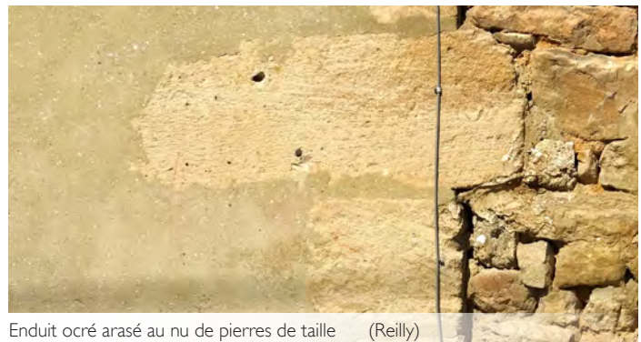
Enduit ocré arasé au nu de pierres de taille (Reilly)
