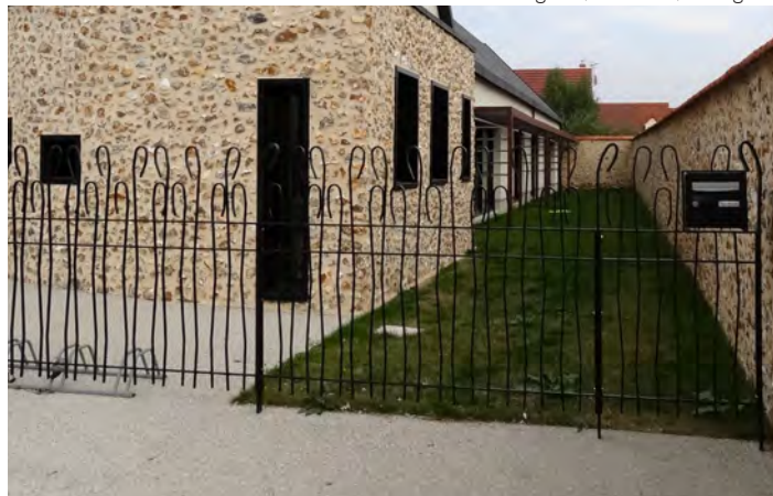
Ferronneries contemporaines formant une clôture (Mignières)
