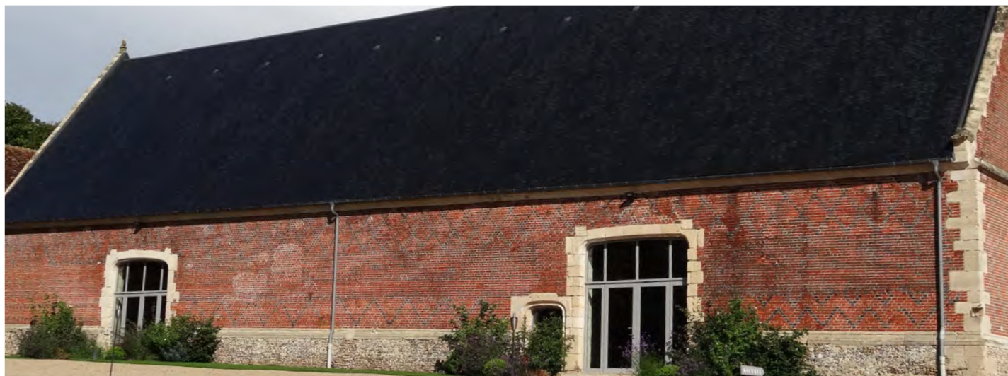
Grange convertie en locaux de séminaire (Boissy-le-Bois)
