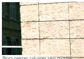
Blocs pierres calcaires sans mortier
