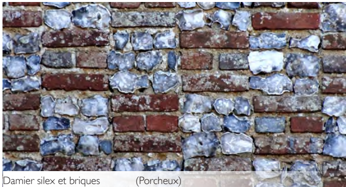
Damier silex et briques (Porcheux)
