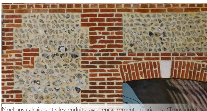
Moellons calcaires et silex enduits avec encadrement en briques (Troussures)
