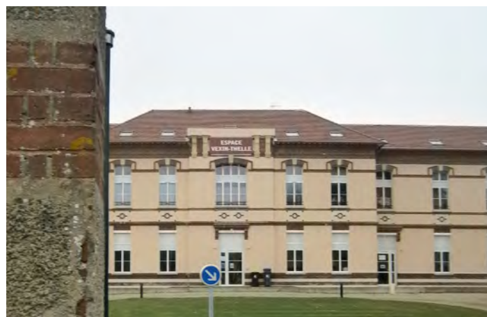
Reconversion d'un équipement public
